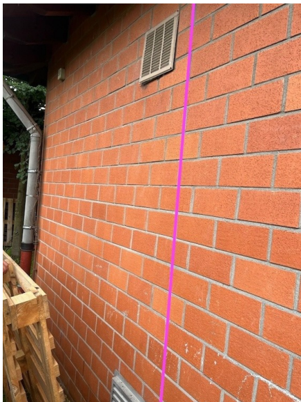
Abbildung 10: Kabelführung DC außen
