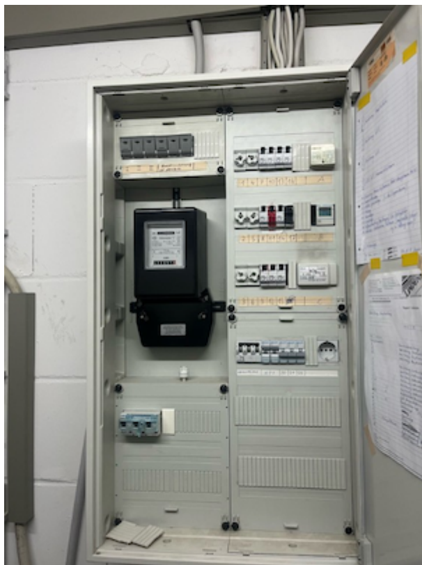
Abbildung 1: Zählerschrank
